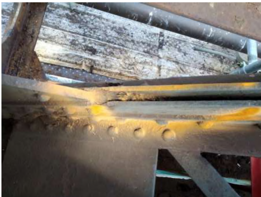
Obr. 4 Typický detail – štěrbina nad dolním pasem
