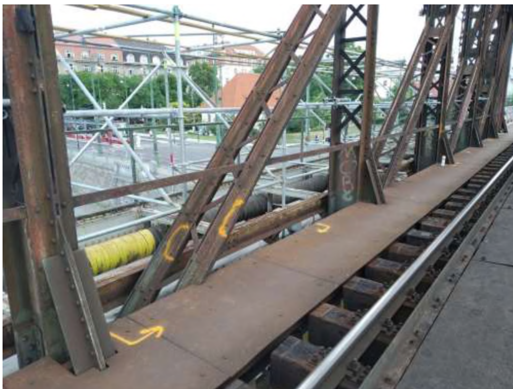
Obr. 5 Pohled na zkoumanou oblast se specifikací rozsahu podlah a vyznačením čištěných míst
