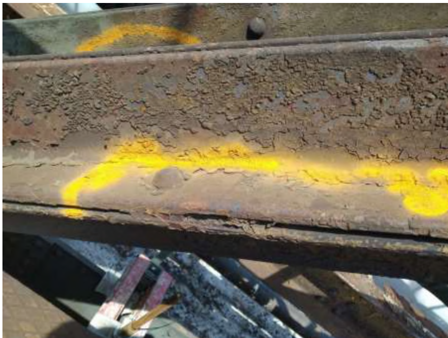
Obr. 1 Typický detail – průchozí štěrbina v diagonále
