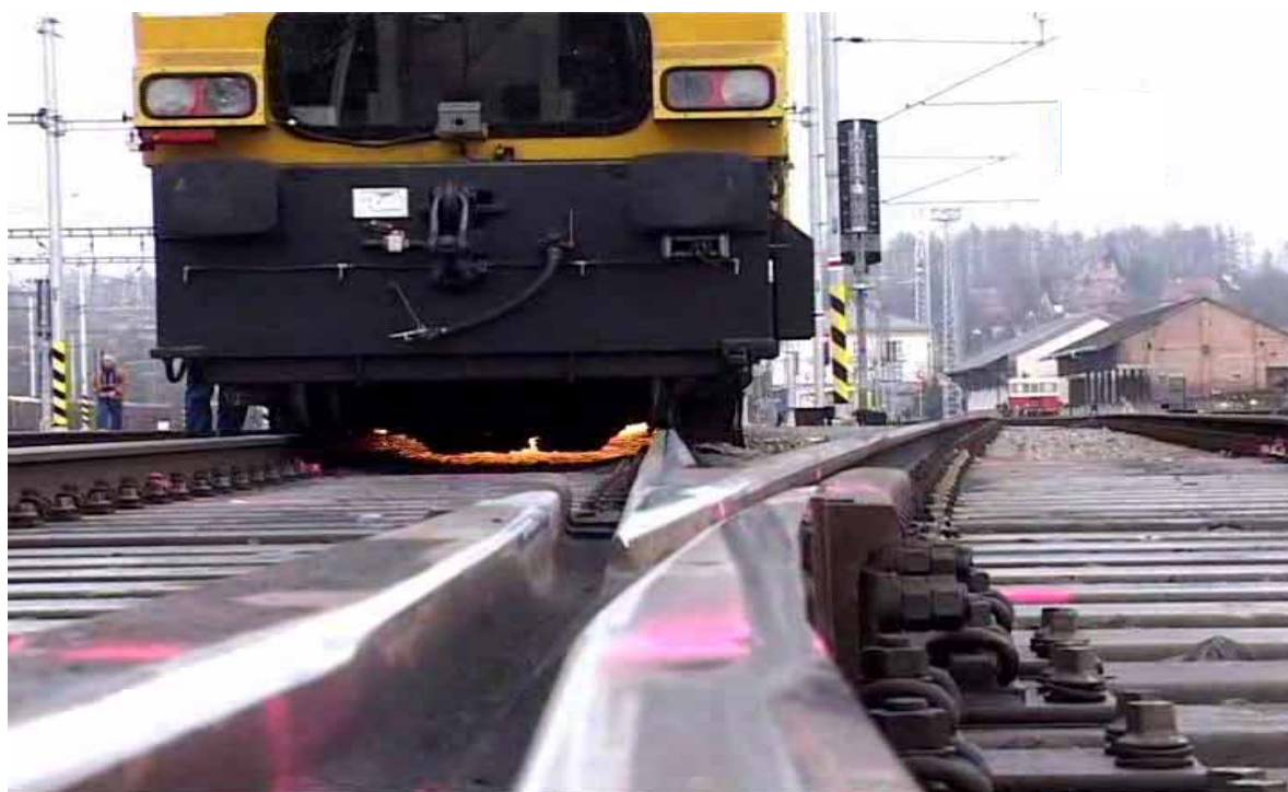
Obr. 1: Broušení velkým traťovým strojem
