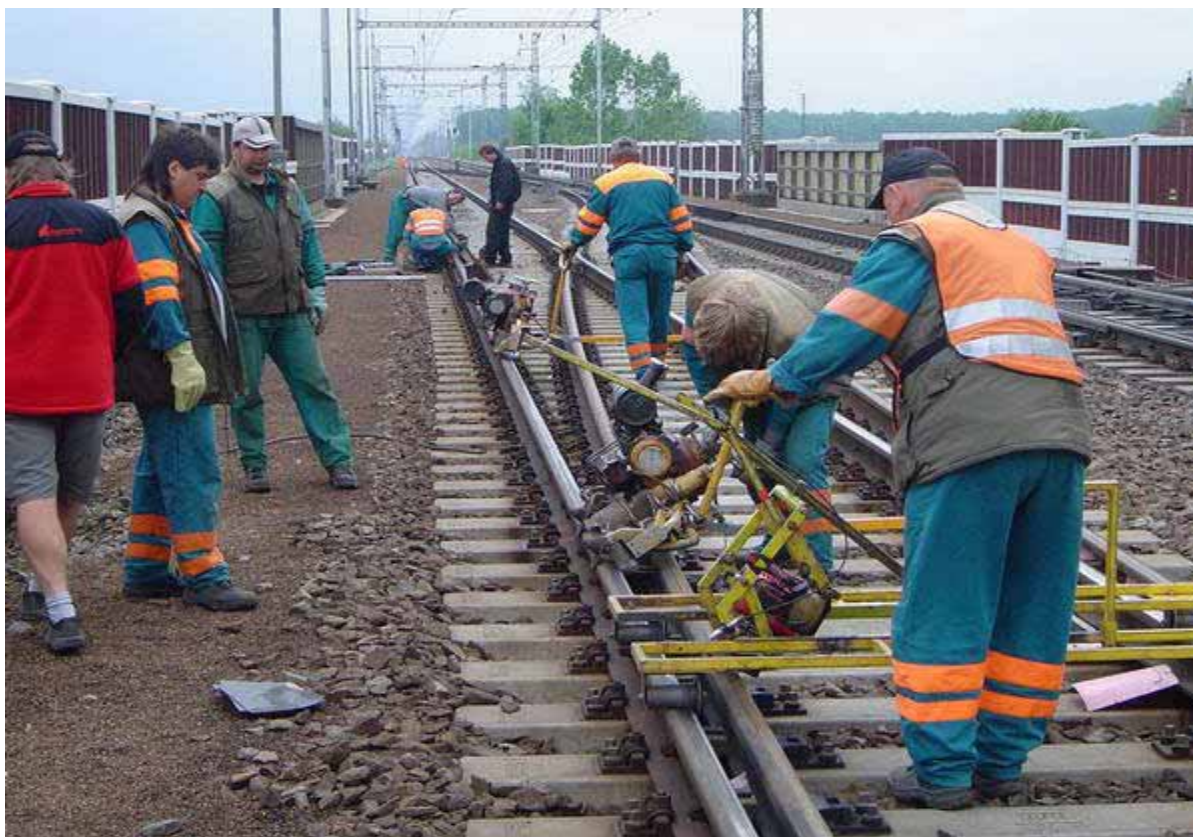
Obr. 2: Broušení ručními bruskami
