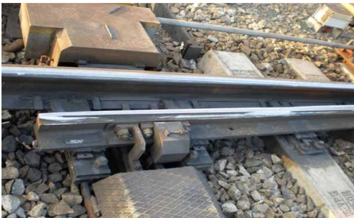
Obr. 6: Jazyk výhybky po broušení
