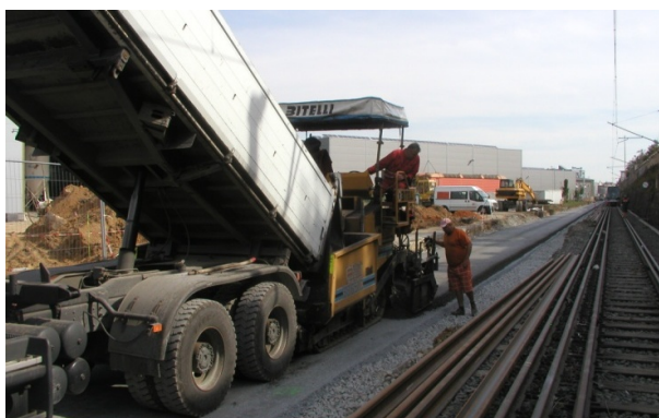
Obrázek 8: Strojní pokládka podkladních vrstev PJD
