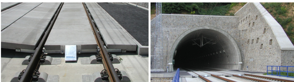
Obrázek 19: Záchranné a přístupové plochy BRENS ACCESS – ŽSR – tunel Turecký vrch
