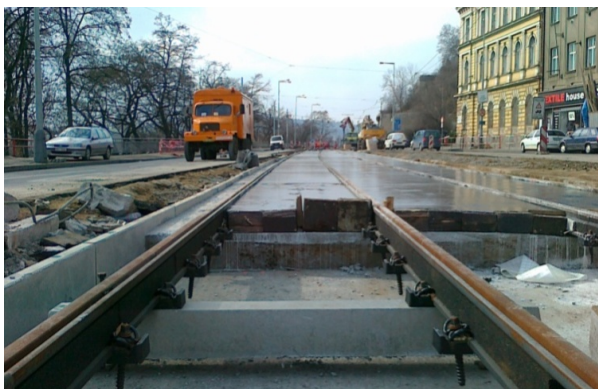
Obrázek 5: Pevná jízdní dráha „W-Tram“ s rektifikační podporou
