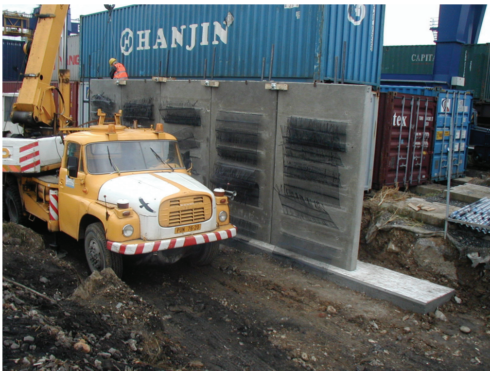
Obr. 2 Stavba protihlukové stěny
