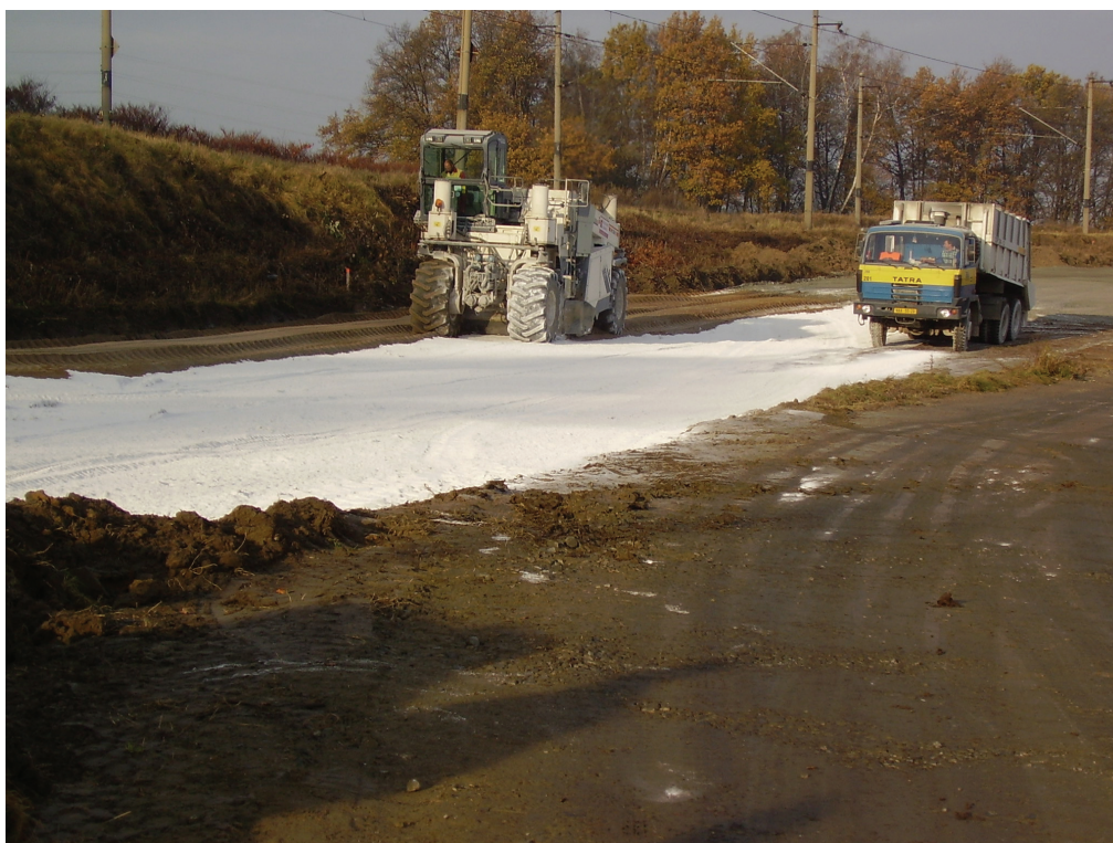
Obr. 1 Zvyšování únosnosti pláně tělesa železničního spodku
