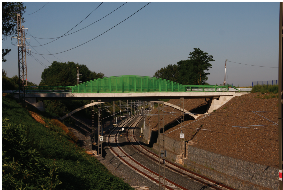
Obr. 3 a 4 Zárubí gabionové zdi s kamenými zídkami u podpěr trakčního vedení
