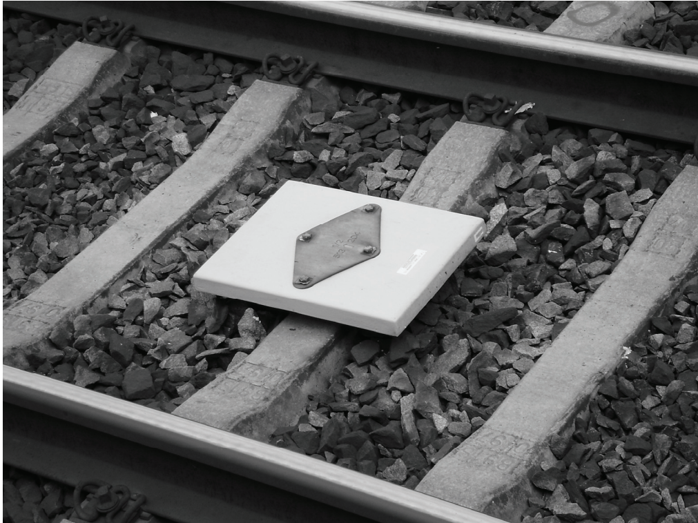
Obr. 1. Eurobalíza v provedení použitém na pilotním projektu ETCS
