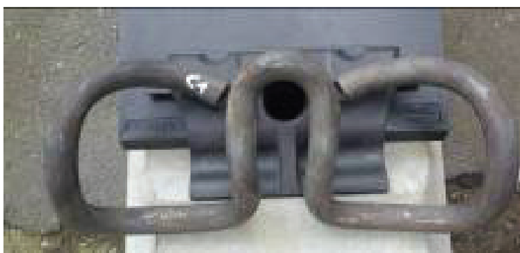
Obr. 5 Systém upevnění s masivní pružnou svěrkou, speciální rozšířenou úhlovou vodicí vložkou a antiabrazivní podložkou na pražci
