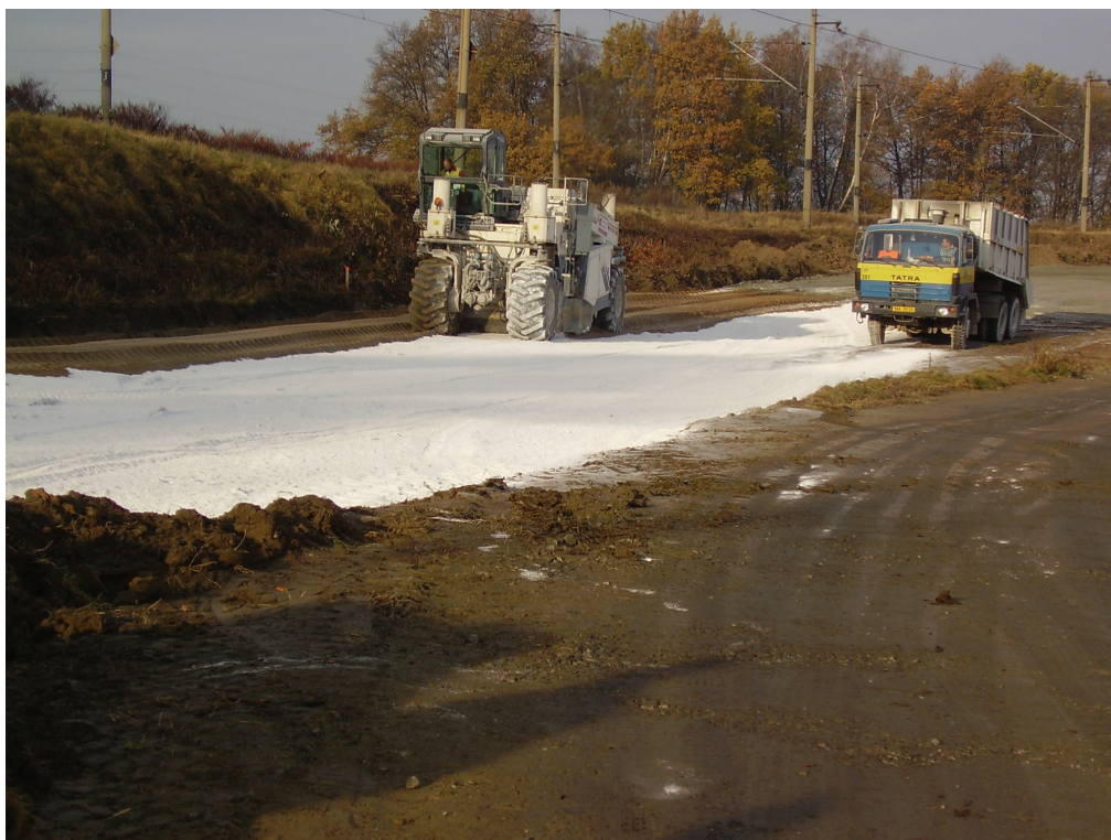
Obr. 1 Zvyšování únosnosti pláňě tělesa železničního spodku
