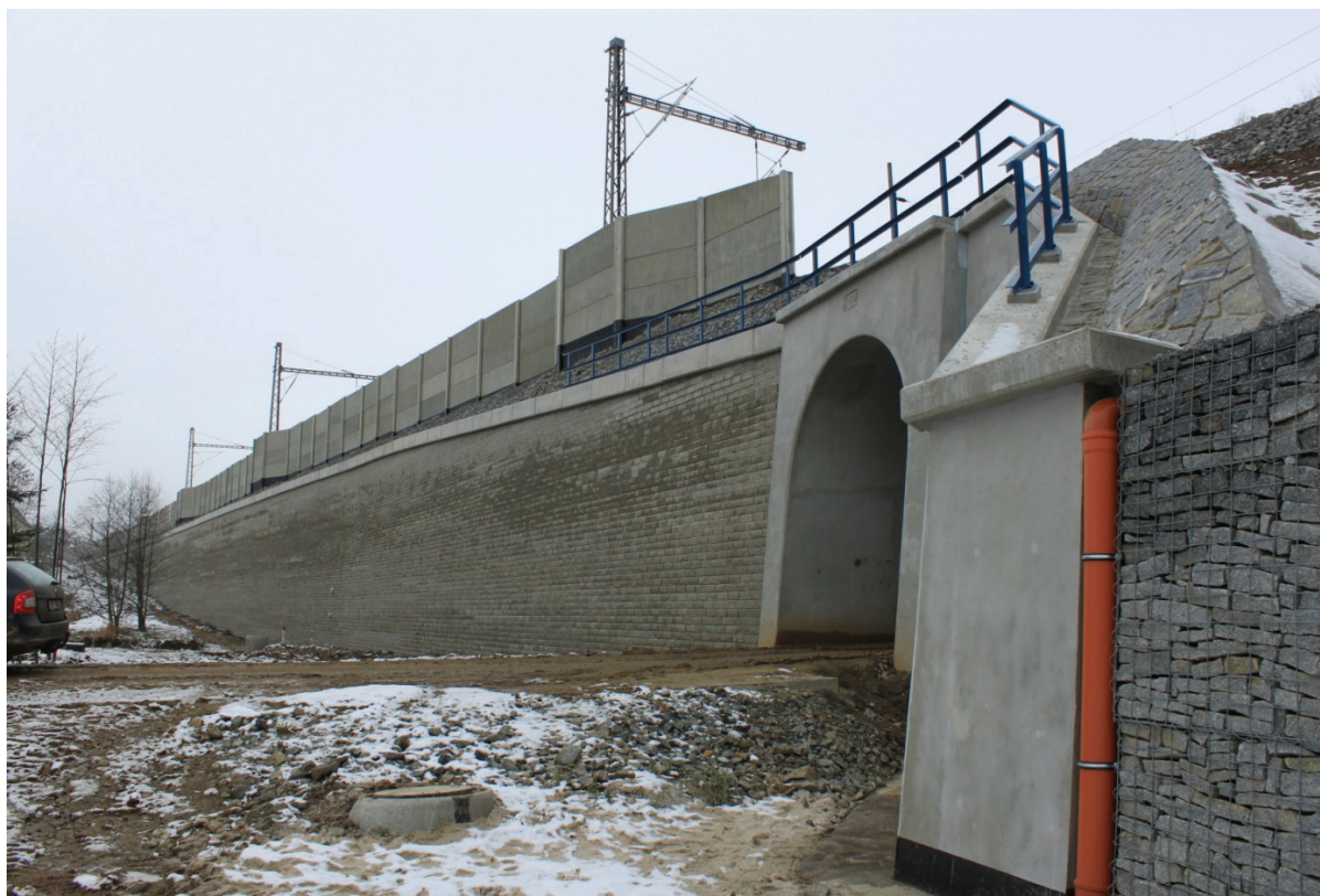
Obr. 5 Pohled na dokončenou zeď, v popředí je i klenutý most, který prodloužil stávající kamenný
