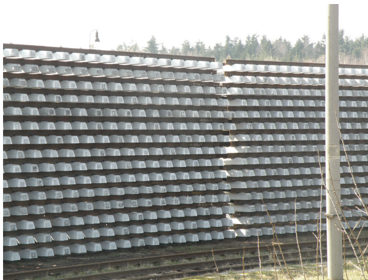
Obr. 2 Nesprávně skladovaná předmontovaná kolejové pole
