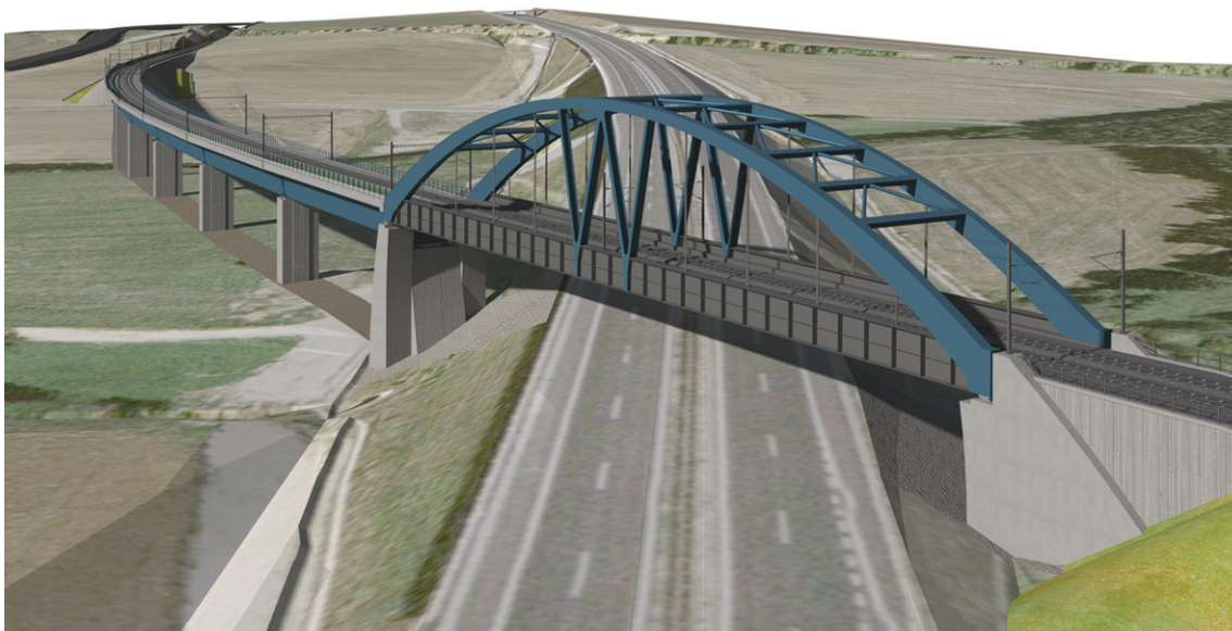
Obr. č. 3 Přemostění dálnice D3 u Chotovin (SUDOP PRAHA a. s.)
