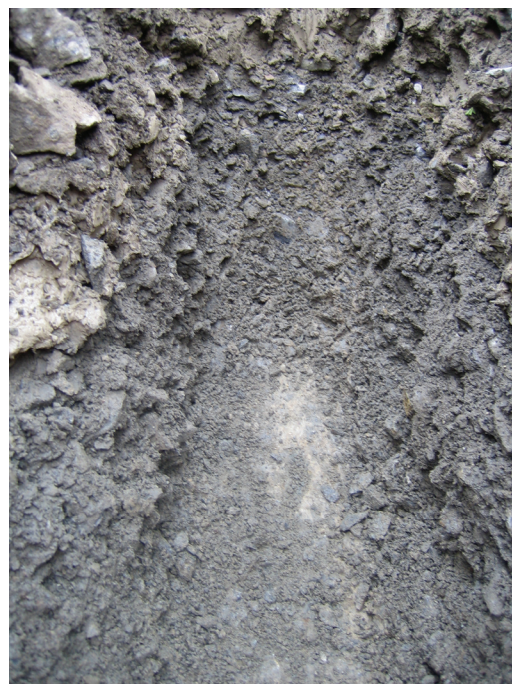
Stav konstrukční vrstvy vody
