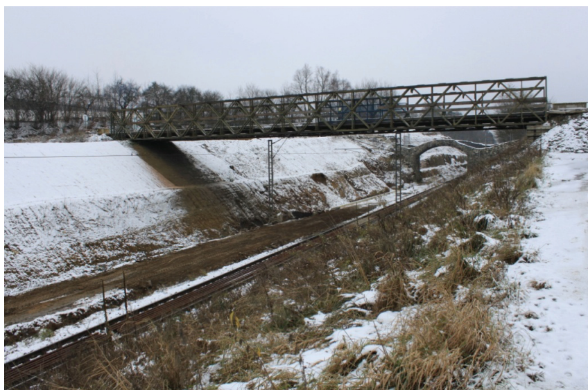
Obr. 1 Mostní provizorium u Střelítova
