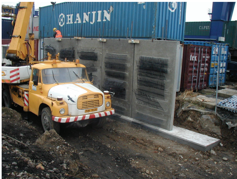
Obr. 2 Stavba protihlukové stěny
