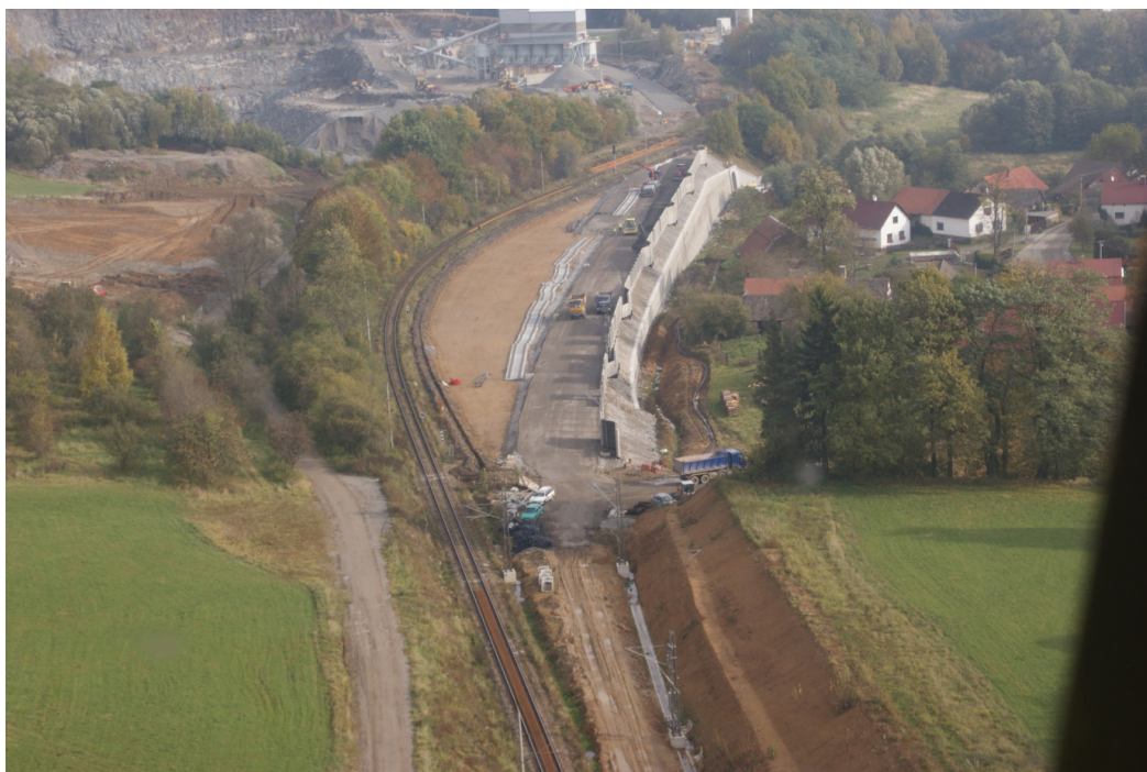
Obr. 4 Pohled na dokončenou zeď z ptačí perspektivy, v pozadí lom ZAPA ve Voticích, který musel částečně ustoupit přeložce trati
