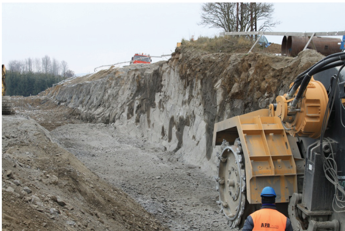
Obr. 6 Skální fréza, skalní podloží je bezprostředně pod povrchem
