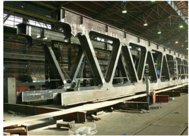
Obr. 6 Výroba ocelové konstrukce v mostárně
