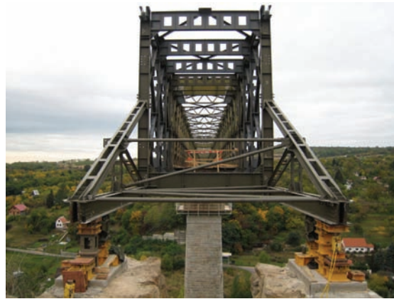
Obr. 8 Uvolnění konce NK do přípustného průhybu na znojemské opěře
