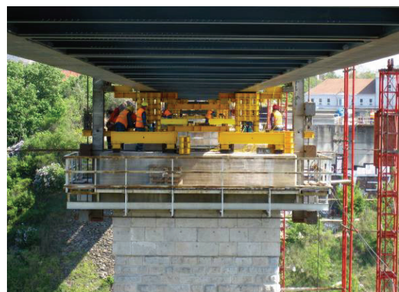
Obr. 12 Spouštění nosné konstrukce o 1,7 m
