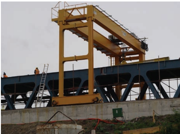
Obr. 5 Montáž OK mostu na montážní plošině
