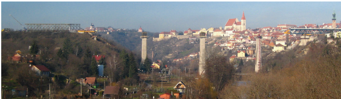
Obr. 4 Souběh demontáže provizorní konstrukce ŽM 16 a výsunu nové ocelové konstrukce
