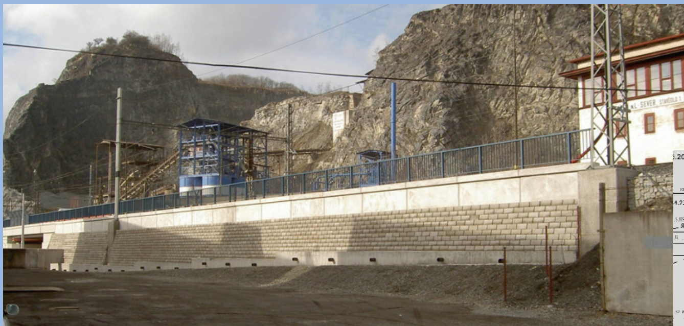
Opěrná zed', Koridor. trať Ústí n. L.- Sever, SO8310; výška 6m, sklon 82°
