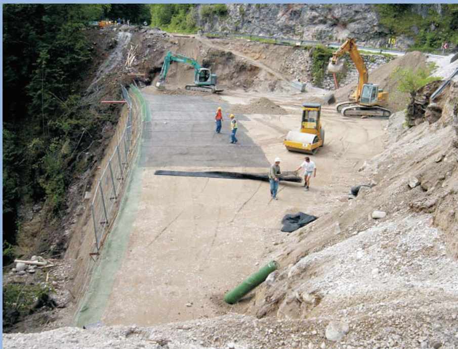
Silnice B115, Abschnitt Rodlauerbrücke, Rakousko; výška 34m, sklon 64°
