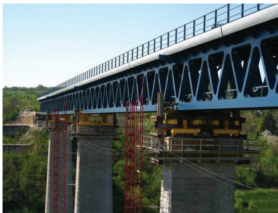
Obr. 11 Demontáž části prvků pro výsuv z pilířů a příprava na spuštění konstrukce
