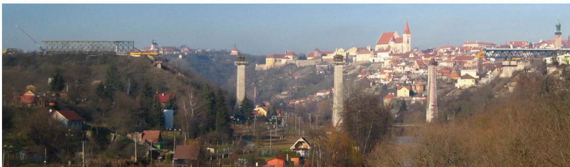
Obr. 4 Souběh demontáže provizorní konstrukce ŽM 16 a výsunu nové ocelové konstrukce
