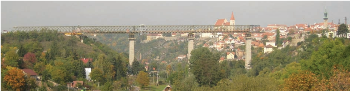
Obr. 3 Provizorní most ŽM 16 M po dokončení 1. etapy výsunu
