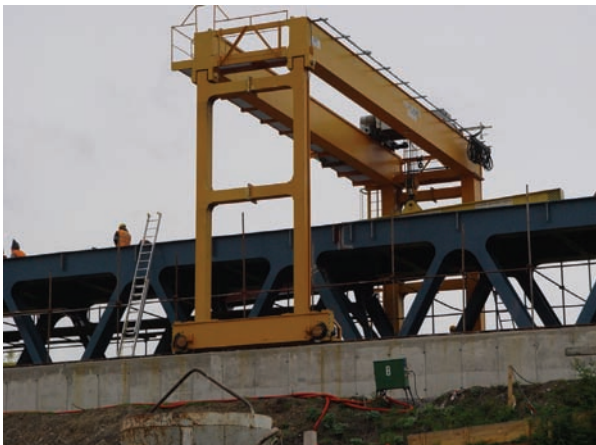
Obr. 5 Montáž OK mostu na montážní plošině
