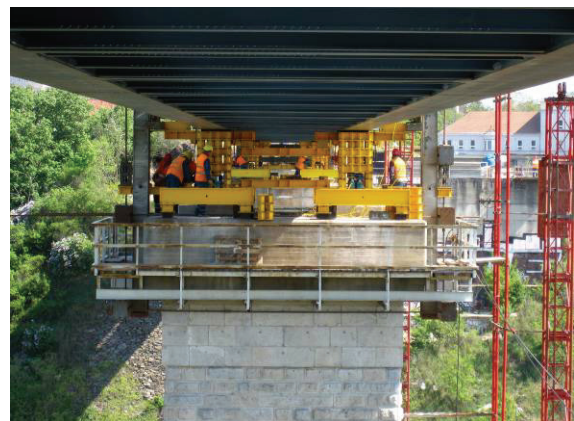
Obr. 12 Spouštění nosné konstrukce o 1,7 m
