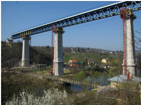
Obr. 9 Výsuv nosné konstrukce ve 4. etapě
