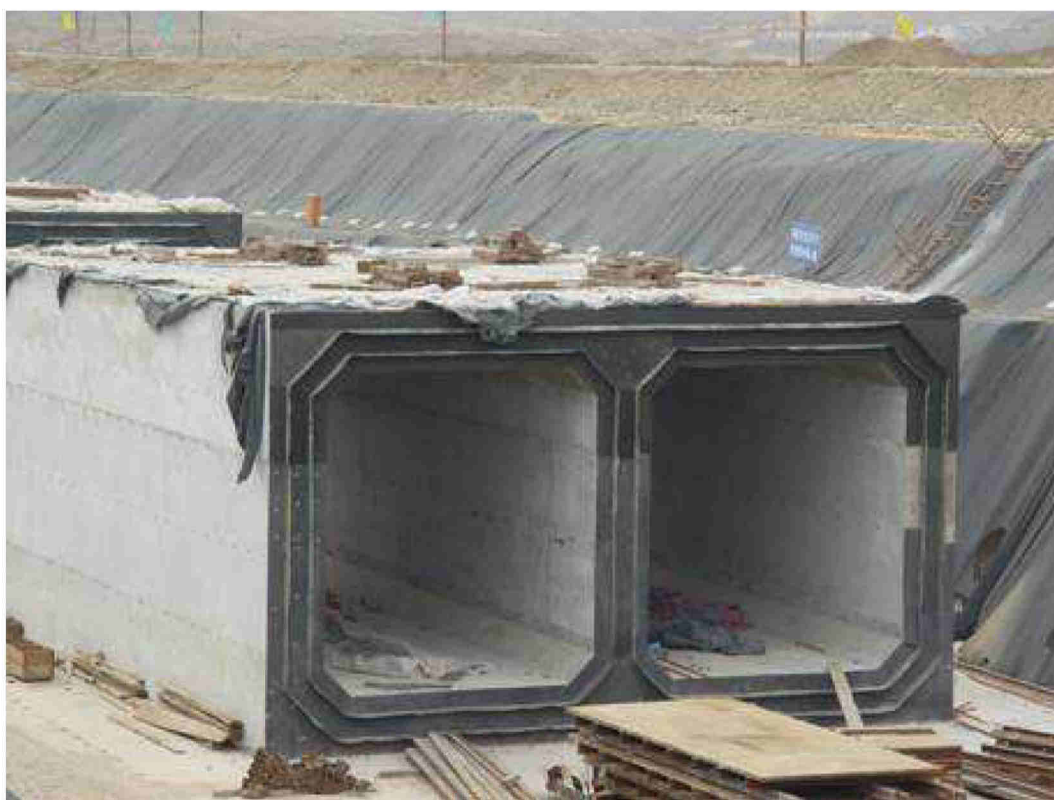
Příklad kvalitního provedení ze zahraničí – kvalitně osazené waterstopy a použití navíc sekundárního (pojistného) waterstopu v jedné spáře
